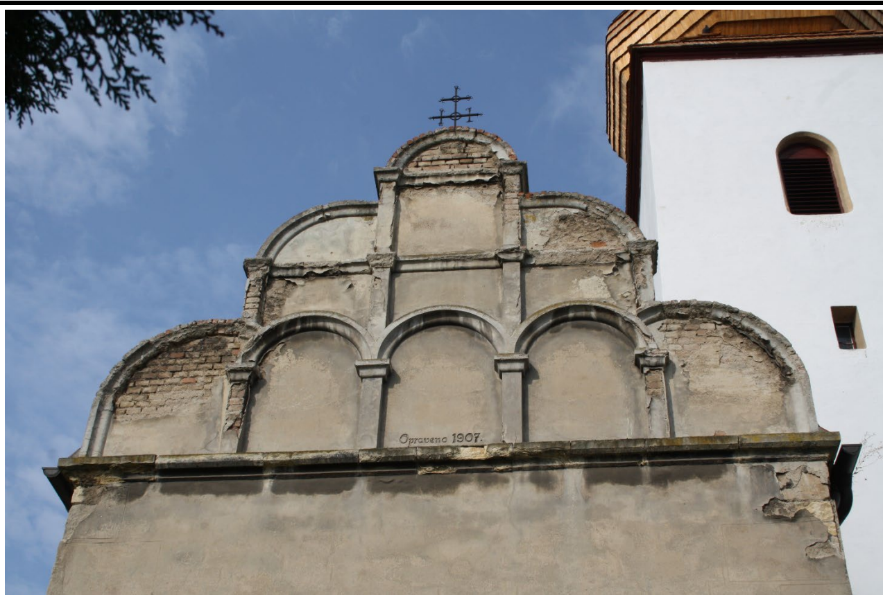
Detail východního štítu presbytáře. Foto: Jaroslav Skopec 2017.
