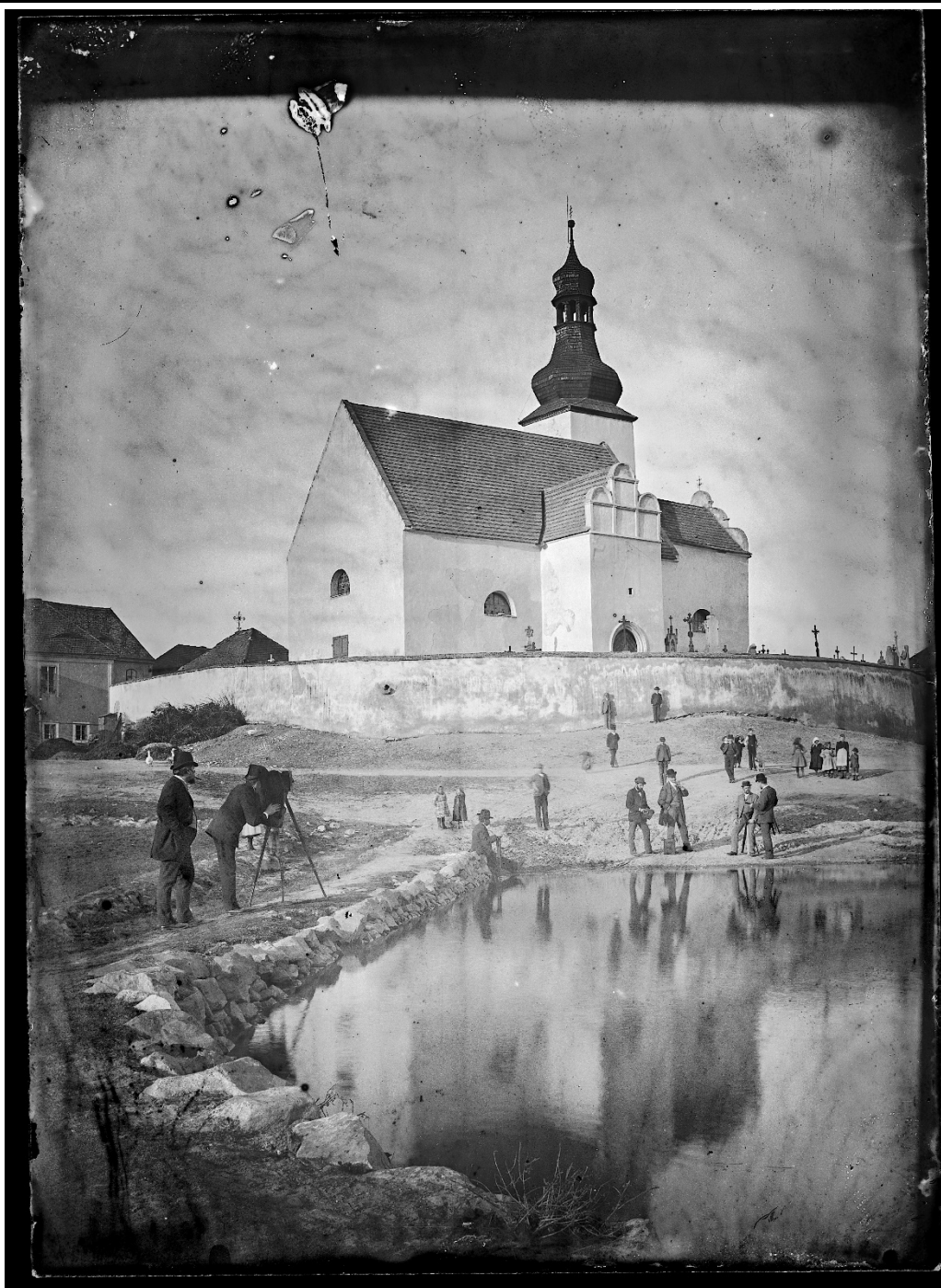
Kostel v pohledu od jihozápadu na fotografii z roku 1896. Na jižní straně lodi a presbytáře jsou doposud patrné termální otvory a na západě lodi obdélný vstup. Foto: Karel Goszler, Oblastní muzeum v Lounech, sbírka historických fotografií.
