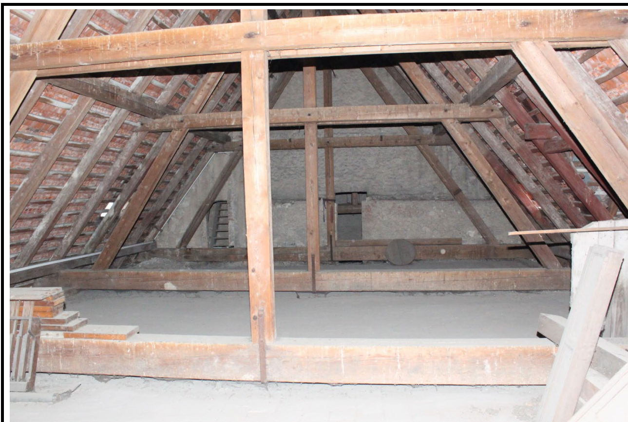
Průhled k východu krovem nad lodí. Foto: Tomáš Brož 2013.
