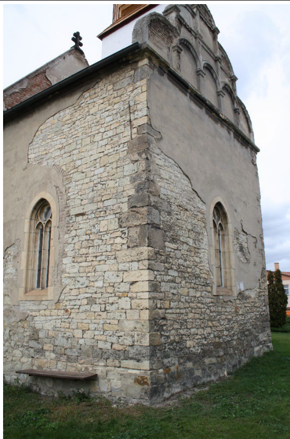
Presbytář v pohledu od jihovýchodu. Foto: Jaroslav Skopec 2017.
