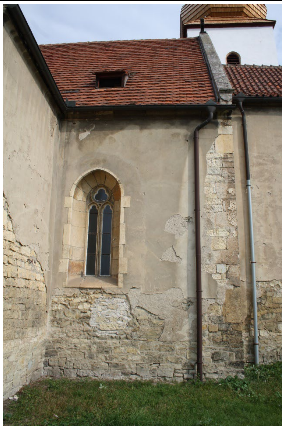
Východní část jižního průčelí lodi v pohledu od jihu. Foto: Jaroslav Skopec 2017.
