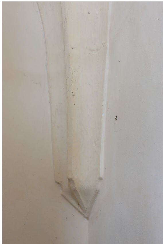
Detail klenebního výběhu v jihochodním koutě presbytáře v pohledu od jihu. Foto: Marta Pavlíková 2018.
