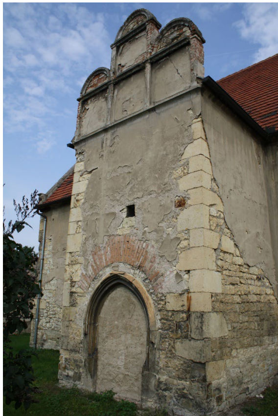
Předsíň v pohledu od jihovýchodu. Foto: Jaroslav Skopec 2017.
