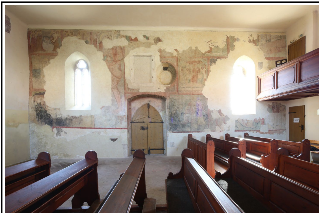
Jižní stěna lodi v pohledu od severu. Foto: Marta Pavlíková 2018.
