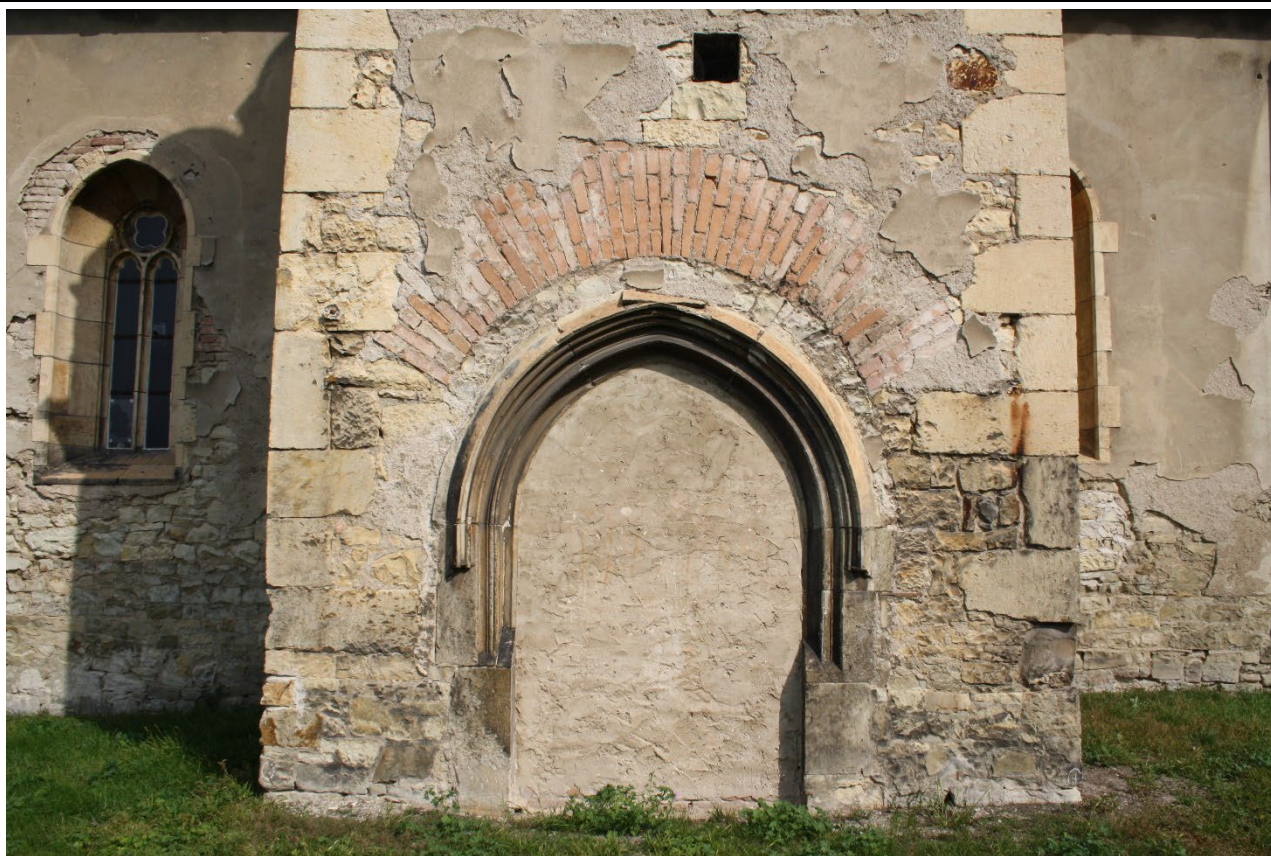
Detail jižního portálu předsíně. Foto: Jaroslav Skopec 2017.
