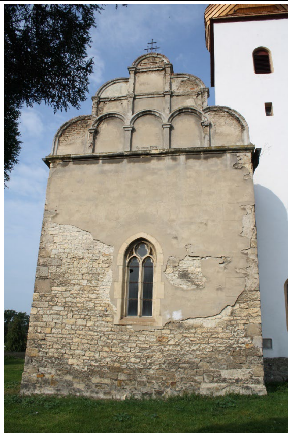
Východní průčelí presbytáře v pohledu od východu. Foto: Jaroslav Skopec 2017.
